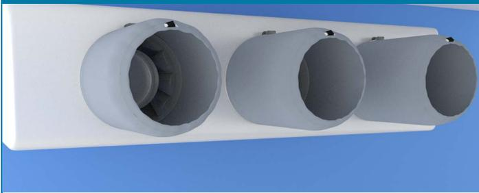
Clapet textile de dégivrage sur une glacière avec ventilateurs qui ne fonctionnent pas (2)
